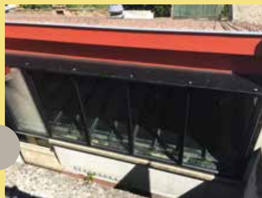
Protection de la verrière en toiture de la salle des fêtes
