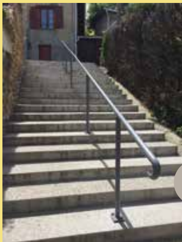
Remise en place d'une main courante Ruelle des Consuls *
