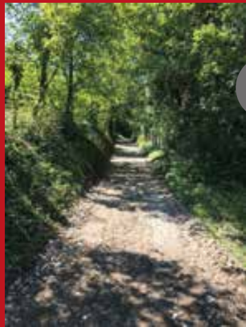
Travaux de remise en forme chemin de la Madone *
