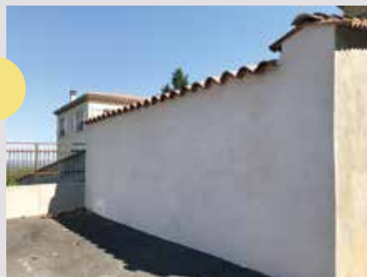
Aménagement d'un muret séparatif Rue des Terreaux* (avec l'aide d'un Morassien bénévole)
