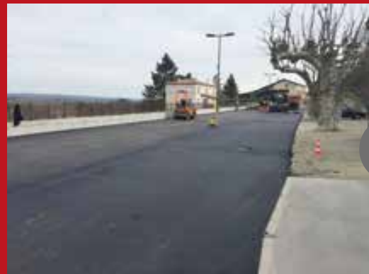
Travaux de voirie Rue des Terreaux
