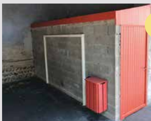
Réfection du cabanon dans la cour de l'école *
