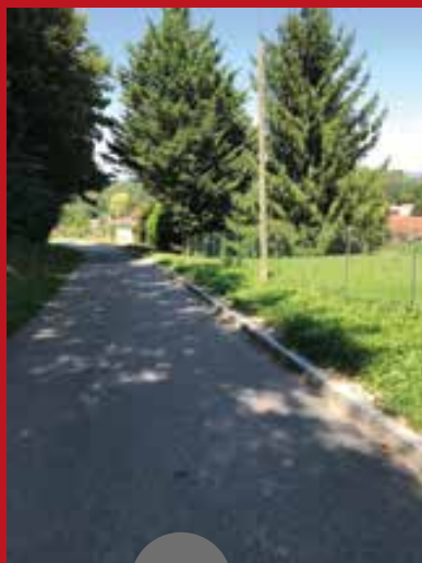
Aménagements de bordures chemin du parc
