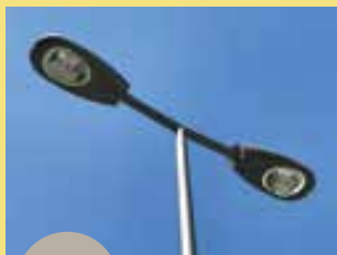
Renforcement de l'éclairage Rue des Terreaux
