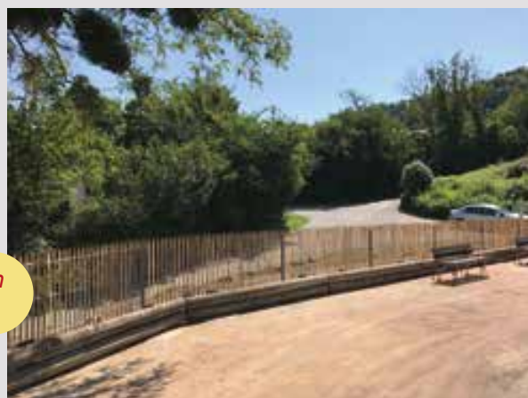
Pose de ganivelles en bordure des jeux de boules au parc *
