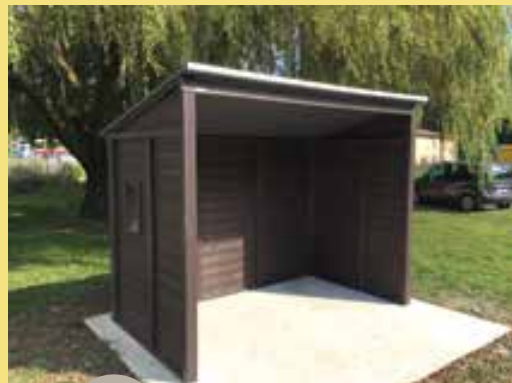
Installation d'un abribus ZA du Val d'Or *
