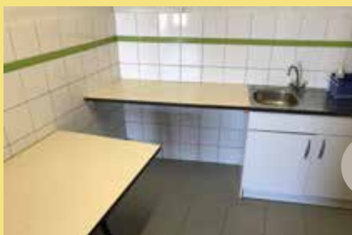
Réfection du local technique de la salle des fêtes *
