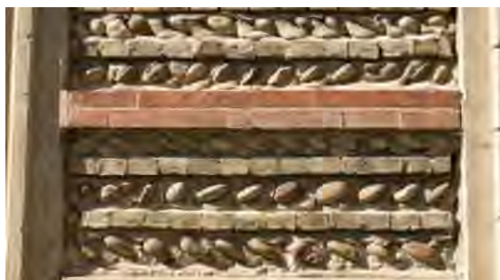
Rangées de galets et de briques
