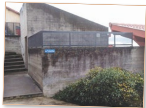
Sécurisation du toit terrasse de la salle des fêtes *
