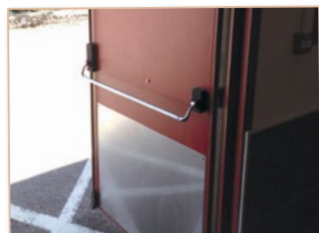
Remplacement de la porte de secours de la salle des fêtes *
