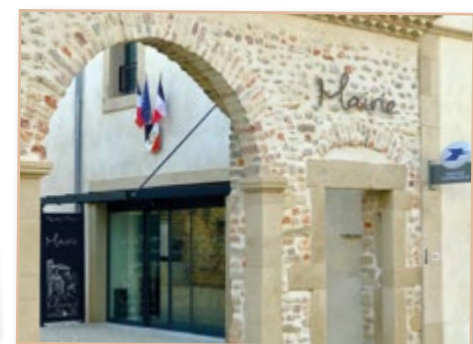
Finitions des travaux de restauration de la mairie *
