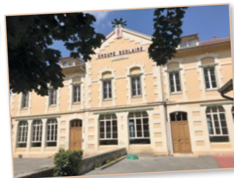
Changement des menuiseries et stores de l'école élémentaire
