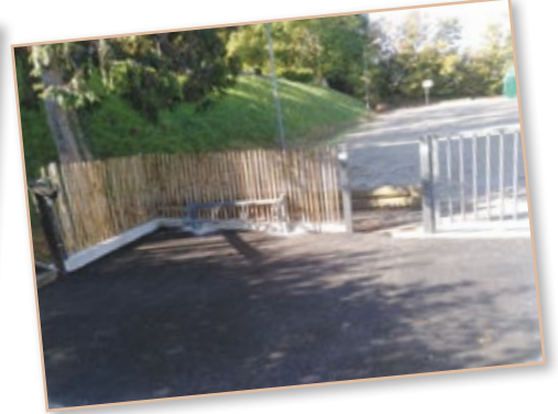
Réfection de l'entrée de l'aire sportive du parc *
