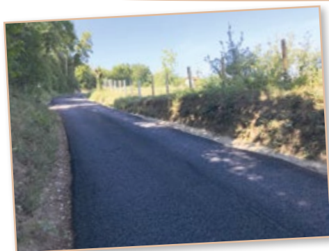
Réfection de voirie Montée de la Madone
