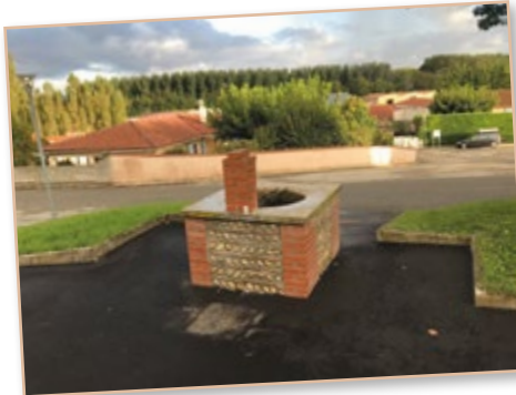
Reprise de sol autour de la fontaine des Ramus
