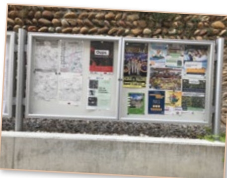
Pose de nouveaux panneaux d'affichage Cour d'entrée de la mairie *
