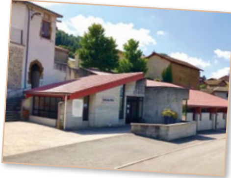
Réfection de la toiture et zinguerie de la salle des fêtes
