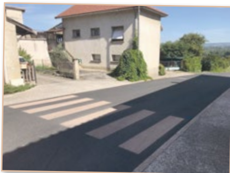
Réfection des passages en résine Rue Maurice Savin et reprises de voirie Route de Fontblanchet
